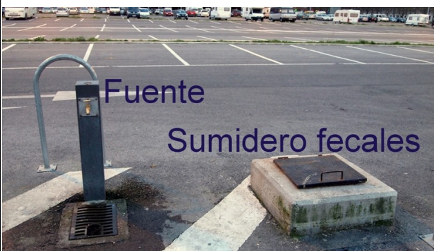
Detalle de la fuente y sumidero de aguas negras (Vitoria)
